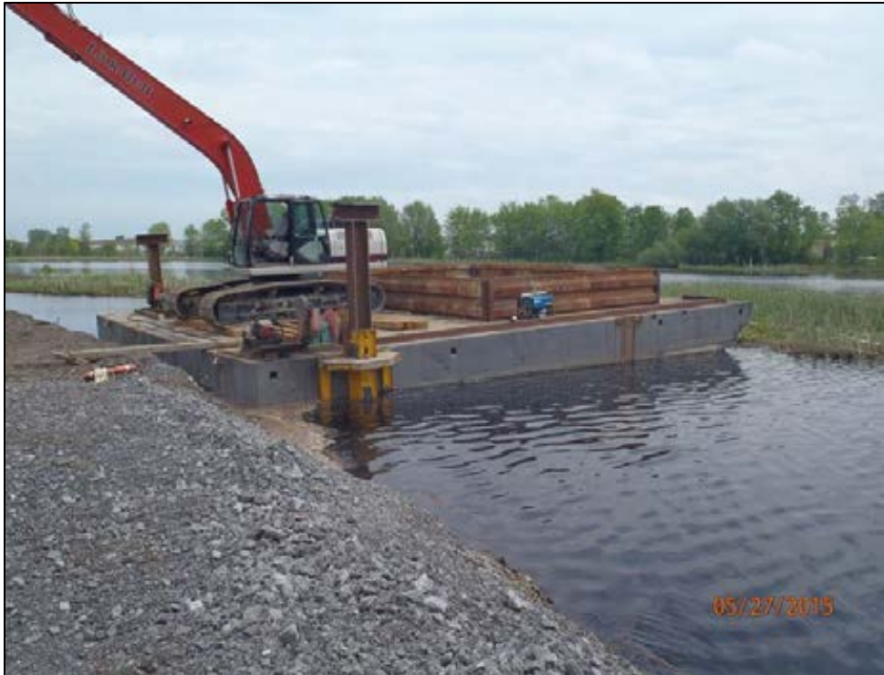
Excavatrice à longue portée sur la barge (mai 2015)
