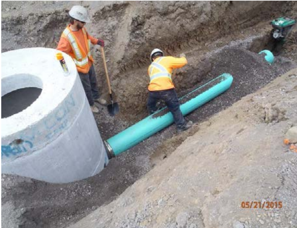
Installation de l'égout sanitaire sous la rue Water (Mai 2015)
