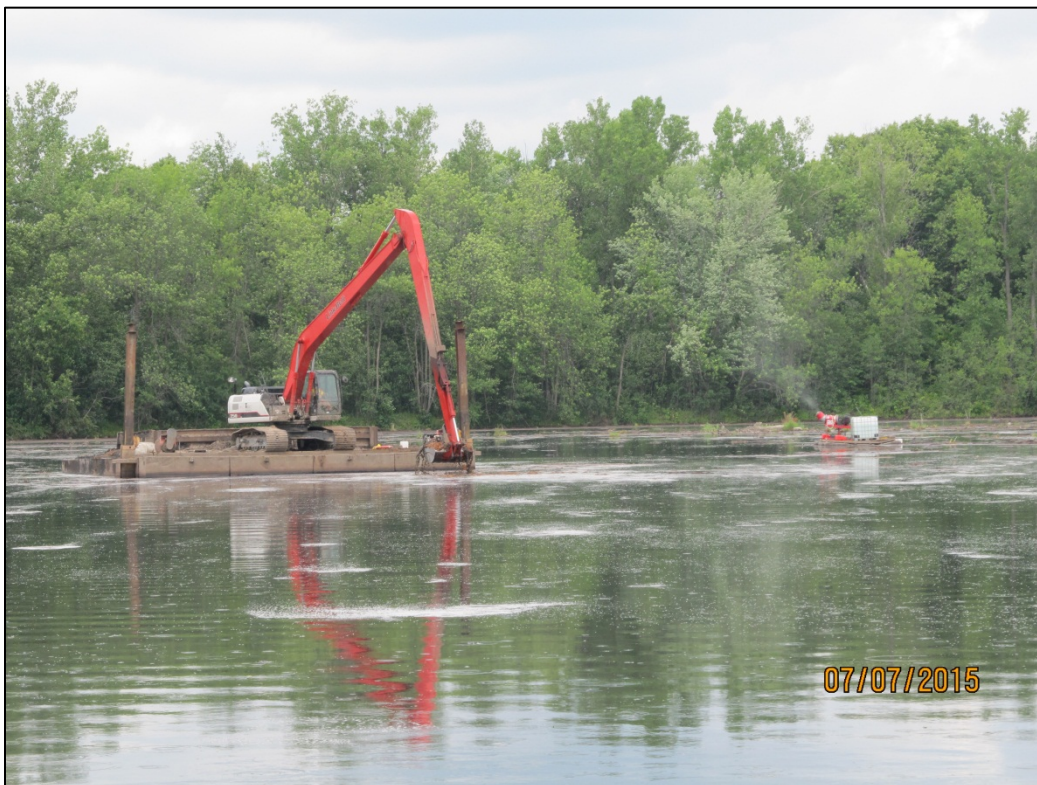
Dragage des boues de la barge avec un brumisateur neutralisant d'odeurs à la droite (juin/juillet 2015)
