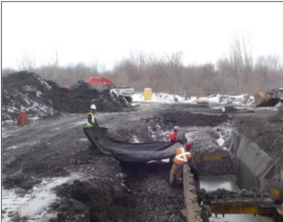
Installation de la toile géotextile dans le drain en gravier (mars/avril 2015)
