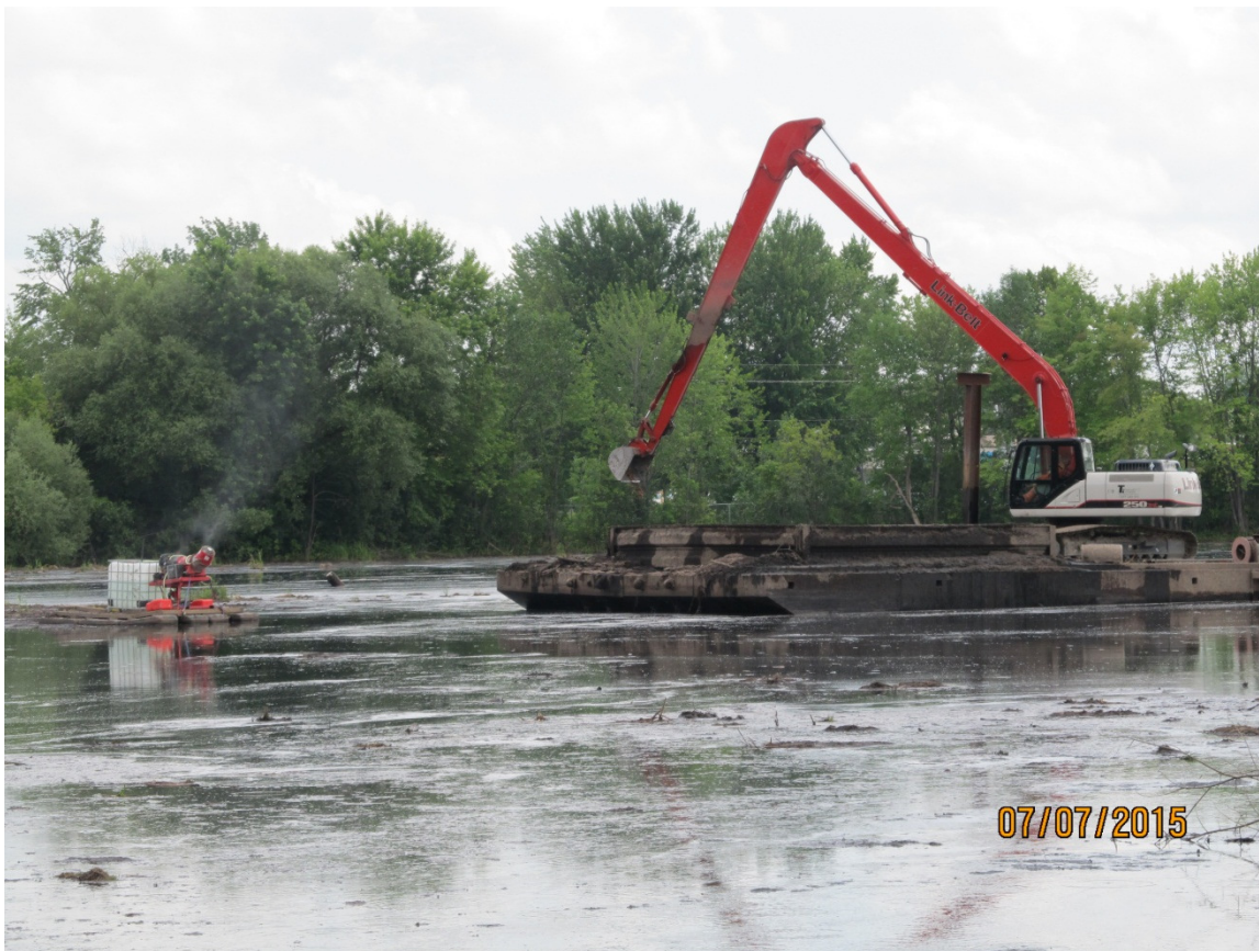
Système de neutralisation des odeurs et excavatrice sur barge à l'étang
